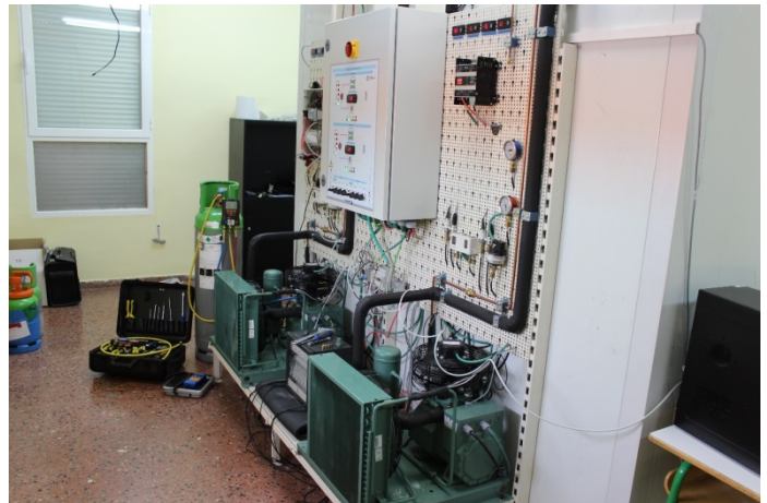
4. Ilustración. EQUIPOS E INSTALACIÓN
